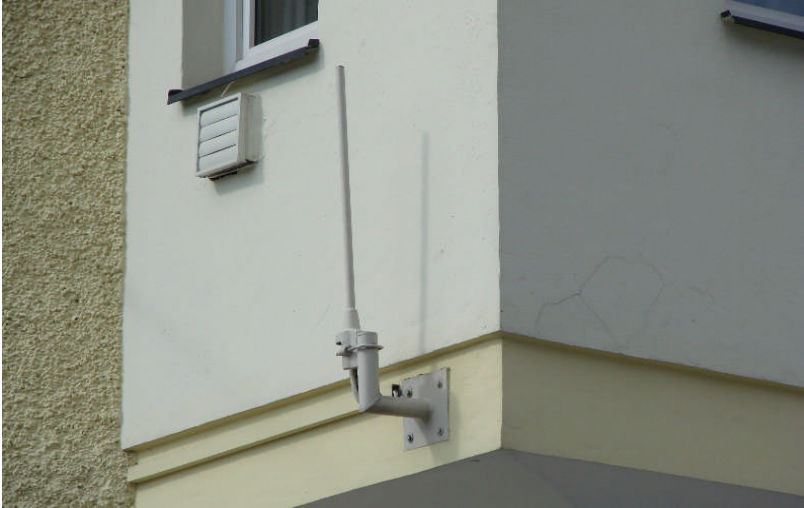
Abb.: Weitere Mikrozellen-Antenne am in der Sterneckstraße dem Testraum gegenüberliegenden Haus – dort waren insgesamt 2 derartige Mikrozellen-Antennen montiert.
