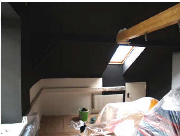
Abb.: Ein Teil des Raumes ist hier bereits mit Y-Shield-Graphit-Abschirmfarbe gestrichen worden. Das hinten links sichtbare Eck wurde (kleiner als hier im Foto gezeigt) von Anstrich freigelassen, um dort die Möglichkeit einer relativ definierten und gut mit veränderbaren Abschirmeinrichtungen überziehbaren „HF-Einstrahl-Tores“ zu schaffen.
